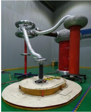
图 17 工频耐压试验平台
