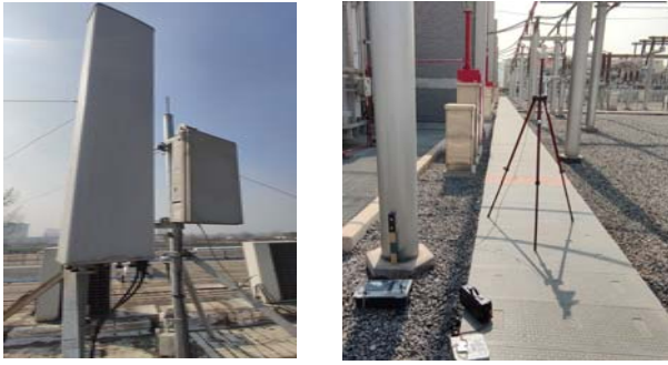
图5 天线位置及接收设备的布置
