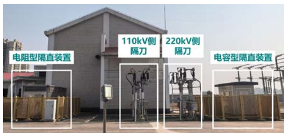
图6 永阳站隔直装置现场安装图
