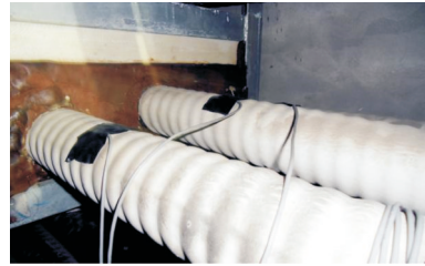
图8 平行排列方式电缆表皮温度传感器布置
