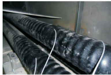
图9 品字型排列方式电缆表皮温度传感器布置
