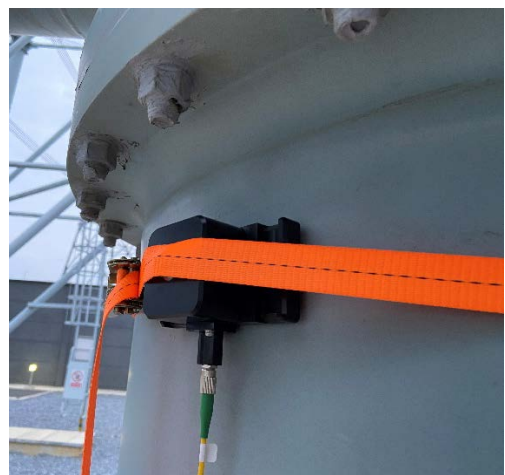
图 8 光纤超声传感器布置
