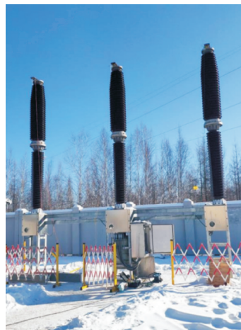
图3 实验用高压断路器
