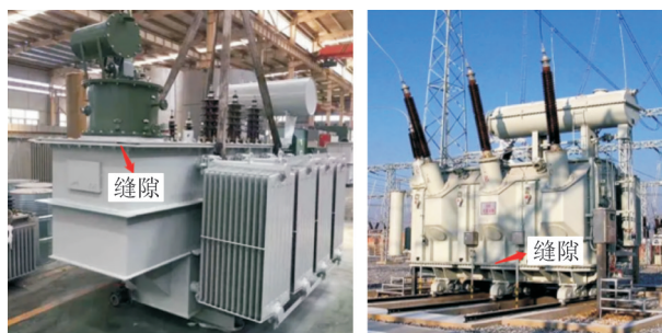
(a) 箱体和顶盖之间缝隙
