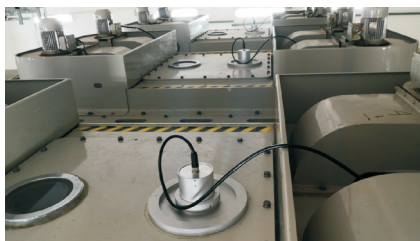
图12 传感器安装实物图
