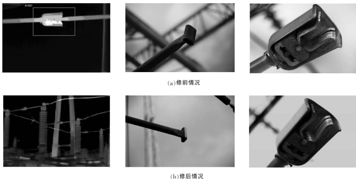
图 6 利用磨光装置不停电处理的前后效果对比
