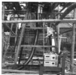
图 2 初始安装时的测试装置
