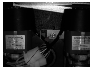
图4 机构箱背面联锁臂和联锁盘的间隙 间隙大于2mm是正常的
