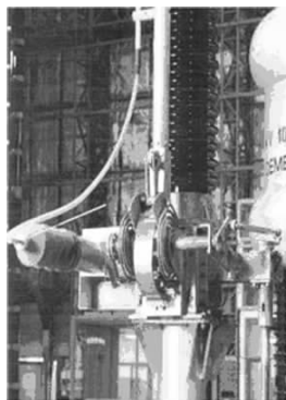
图 2 AREVA STB+CK 型接地 开关配用的 SF 6 灭弧室
