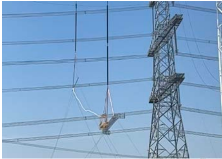
图 8 大型吊篮的间隙放电路径 Fig. 8 Gap discharge path of large hanging basket
